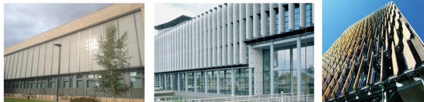
遮阳百叶有效的降低阳光直射造成的日晒
